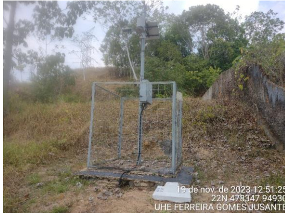
Figura 183 - Jusante – Vista geral do cercado.
