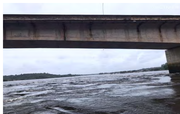
Vista de Jusante
