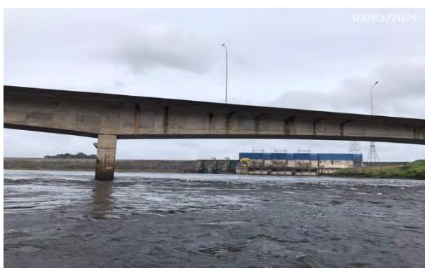
Vista de Montante
