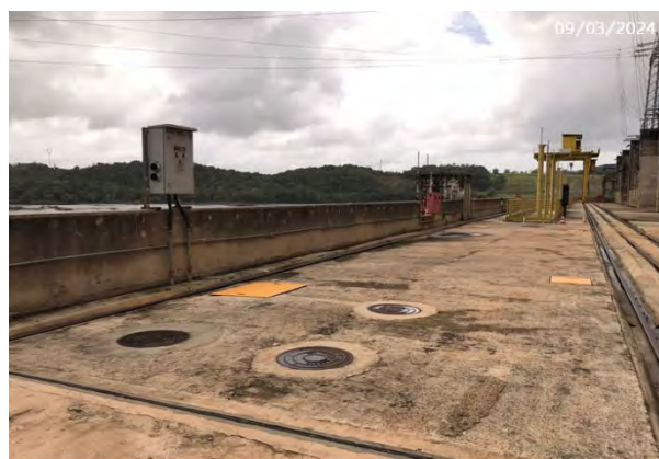
CSAO 2 – Transformadores e gerador (elevação 14)
