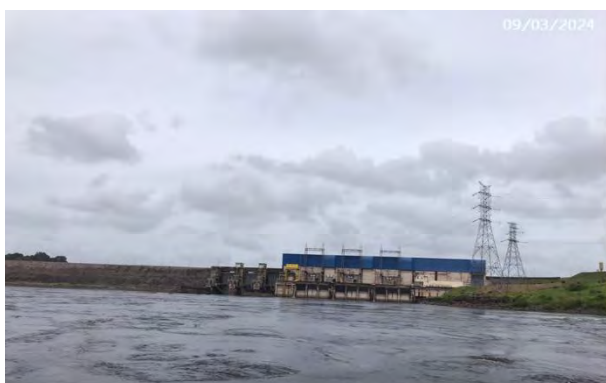
Vista de Montante
