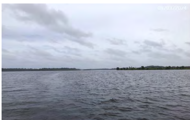
Vista de Montante
