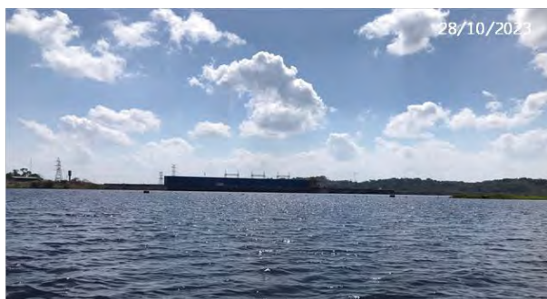
Vista de Jusante
