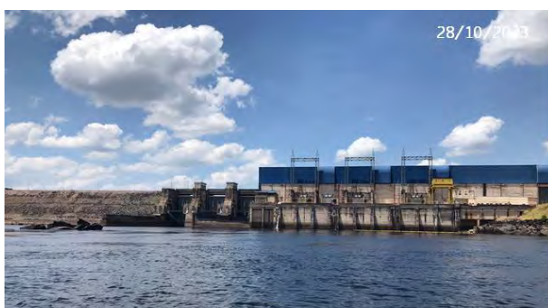
Vista de Montante
