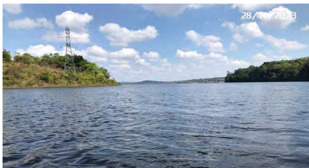
Vista de Montante
