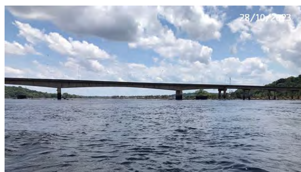
Vista de Jusante
