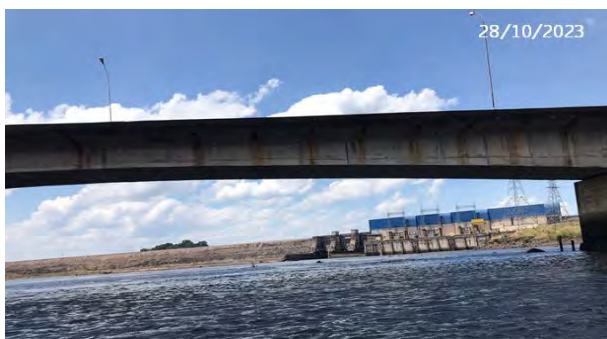
Vista de Montante
