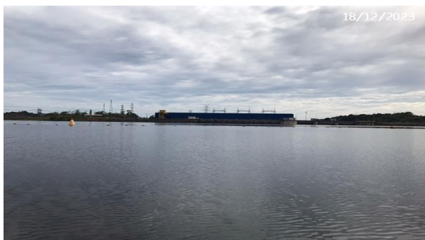
Vista de Jusante
