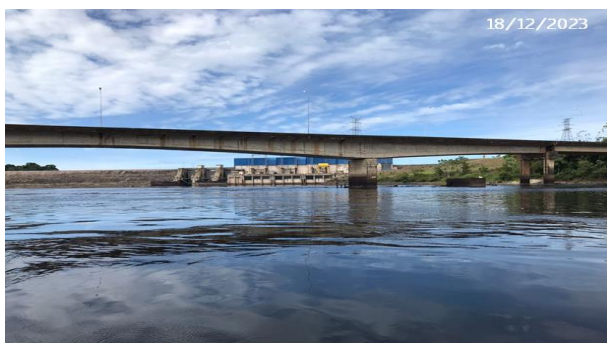
Vista de Montante
