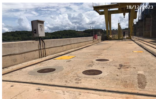
CSAO 2 – Transformadores e gerador (elevação 14)
