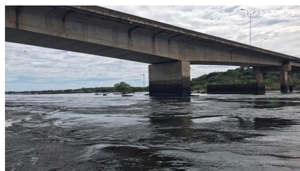
Vista de Jusante
