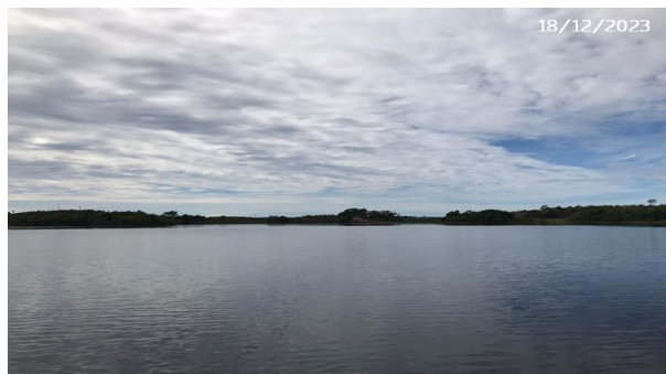
Vista de Jusante
