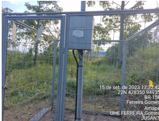
Figura 9 - Jusante – Vista externa PCP.
