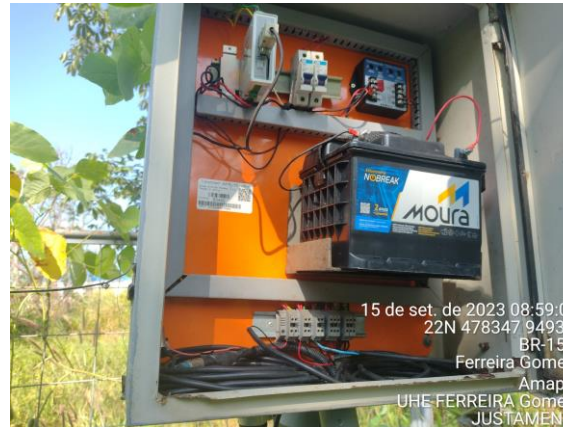
Figura 10 - Jusante – Vista interna PCP.
