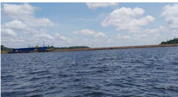
Vista de Jusante
