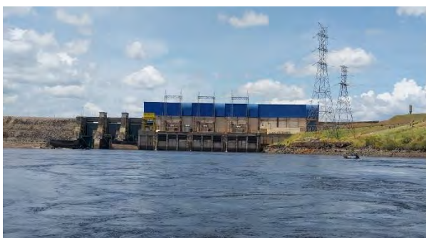
Vista de Montante
