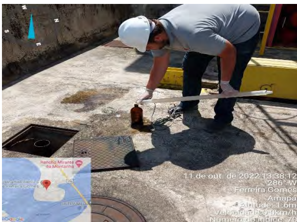
Coleta de efluentes na fossa séptica.
