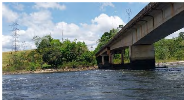
Vista de Jusante
