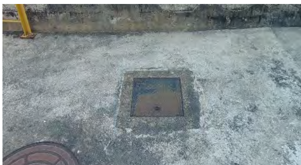
ETE 1 – Casa de Força (elevação 14)
