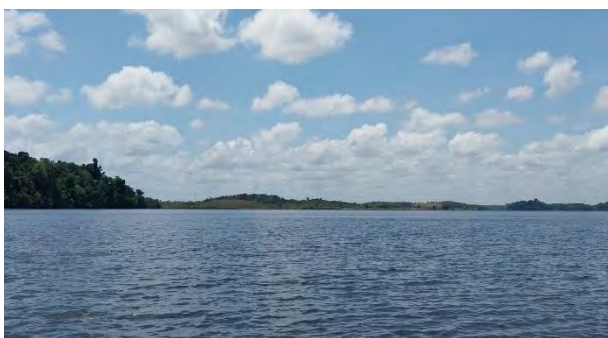
Vista de Jusante
