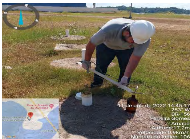
Coleta de efluentes na fossa séptica.
