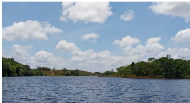
Vista de Jusante
