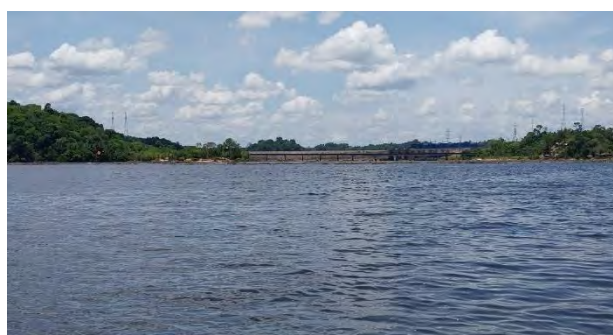
Vista de Jusante
