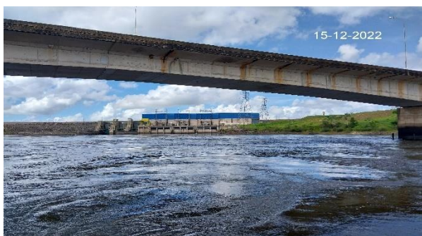
Vista de Montante
