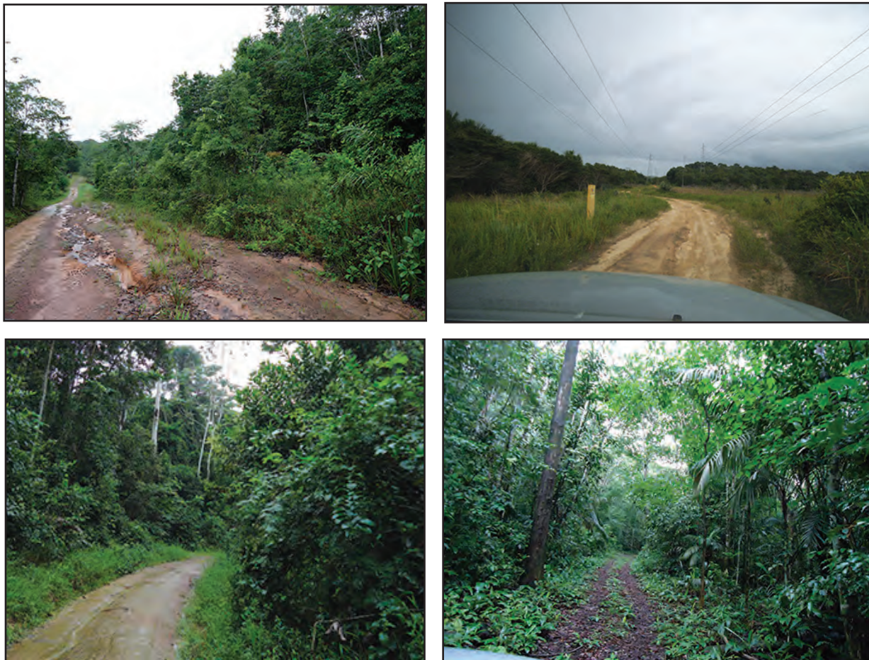
FIGURA 81. Situação das estradas vicinais de acesso ao reservatório.
