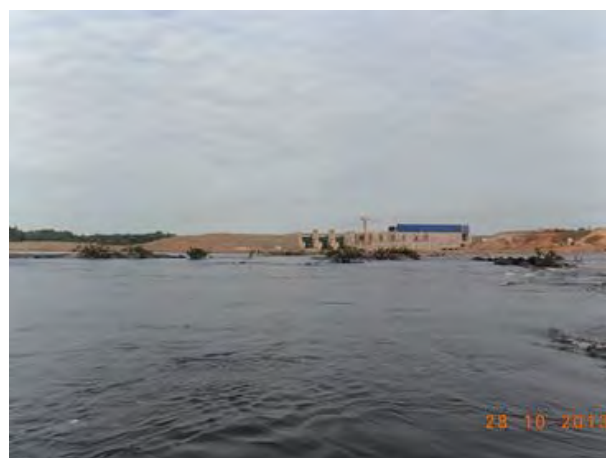
Figura 12. Foto mostrando as condições de navegação a montante da ponte da BR156 sobre o rio Araguari.
