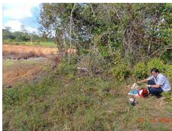
Figura 52. Poço de monitoramento localizado a montante das obras (Pt14FG). Nota-se que a grade de proteção da boca do poço foi retirada e há um canteiro de obras no local.
