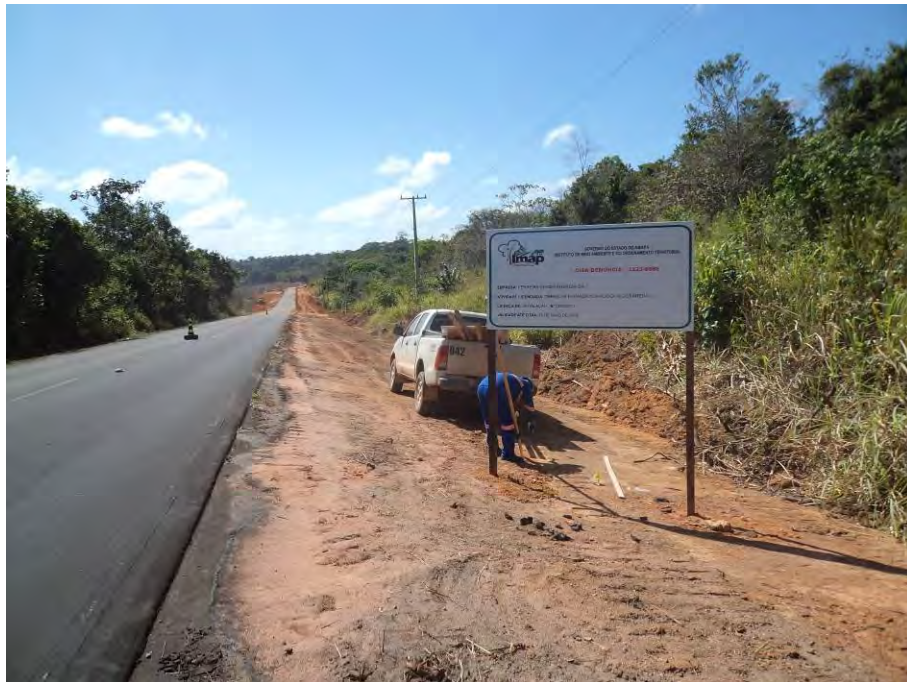
Figuras 5.1 – Instalação de placas de licenciamento ambiente na rodovia do paredão.
