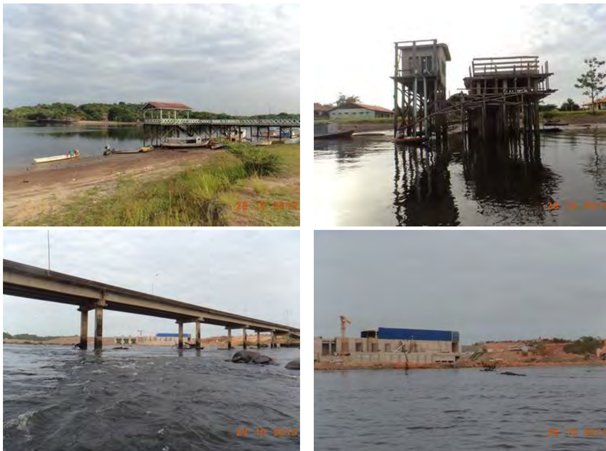
Figura 1. Fotos do rio Araguari nos arredores do local da construção da UHE Ferreira Gomes no Rio Araguari – Fotos obtidas em outubro de 2013.
