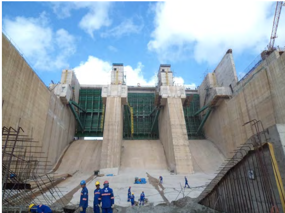
Figura 1.2.2 – Término da concretagem do Vertedouro a jusante.
