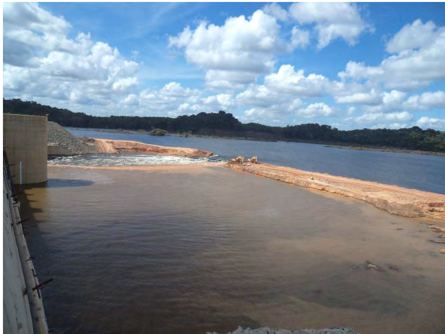
Figura 1.4.3 – Remoção da ensecadeira a montante da Tomada d'água (desvio do rio).
