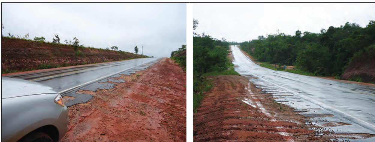
FIGURA 75. Vista parcial da rodovia BR-156 na área do PACUERA.
