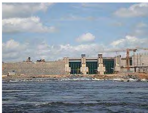
Figura 50. Foto da vista das obras do AHE Ferreira Gomes em 01/10/2013.
