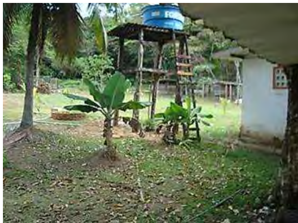
Figura 47. Foto mostrando o sistema de abastecimento por água de poço no Hotel Tassus (Pt13FG) a jusante das obras de construção da barragem.
