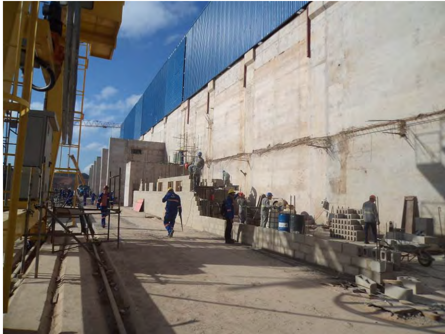
Figura 1.3.3 – Construção das Sala de comando e escritórios da Área de montagem.
