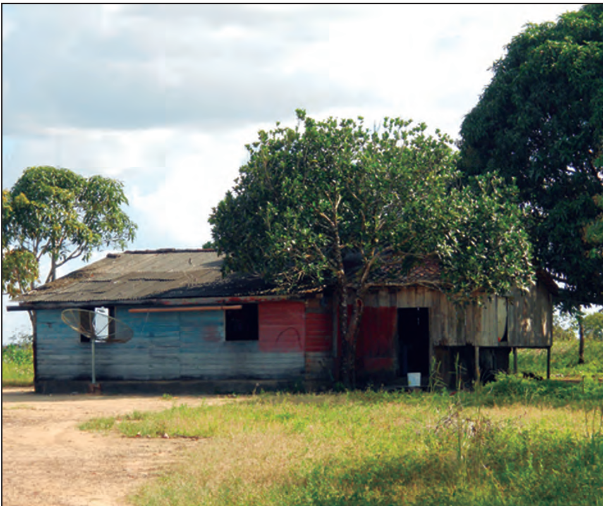
FIGURA 128. Vista geral de uma residência na Comunidade da Terra Preta, Ferreira Gomes, 2012.
