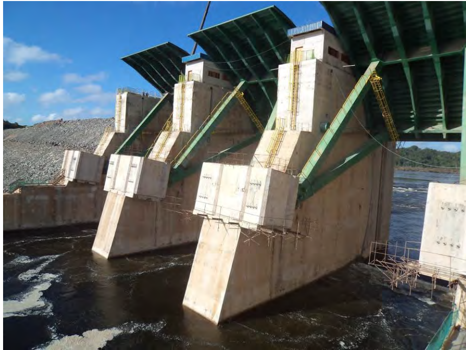
Figura 1.2.3 – Desvio do rio pelo Vertedouro.
