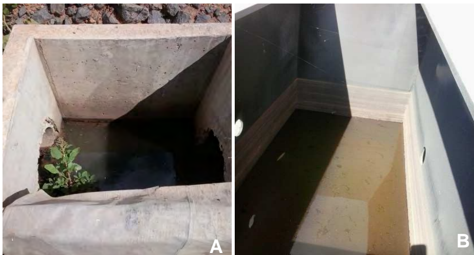
Figura 5 (A e B) - Vistoria em locais alagados do canteiro, como caixas de sumidouros e estruturas de ferro no pátio TSK.
