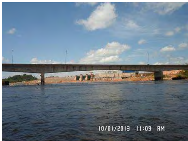
Figura 35. Foto da vista da ponte da BR-156 sobre o rio Araguari mostrando as condições climáticas no dia 01/10/2013.
