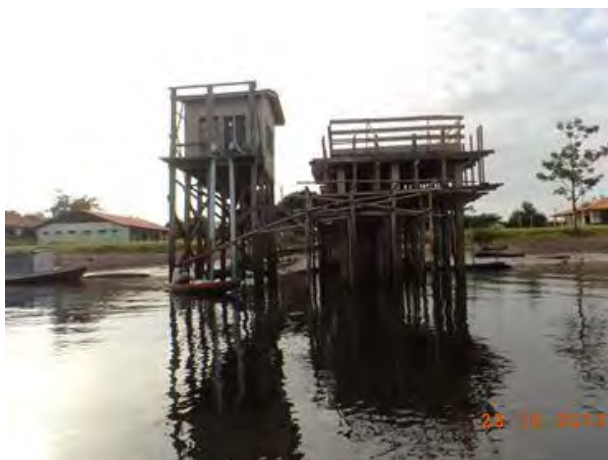
Figura 7. Foto do local de amostragem referente ao Ponto Pt02FG localizado à jusante da construção da barragem da UHE Ferreira Gomes, em frente à bomba de captação de água da CAESA.
