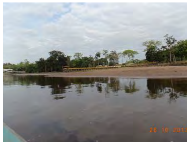
Figura 8. Foto do local de amostragem referente ao Ponto Pt04FG localizado à jusante da construção da barragem da UHE Ferreira Gomes. Nota-se o baixo nível da água no dia da realização da campanha de outubro de 2013.
