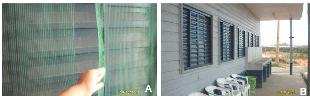
Figura 4 (A e B) - Vistoria nas telas de proteção dos prédios.
