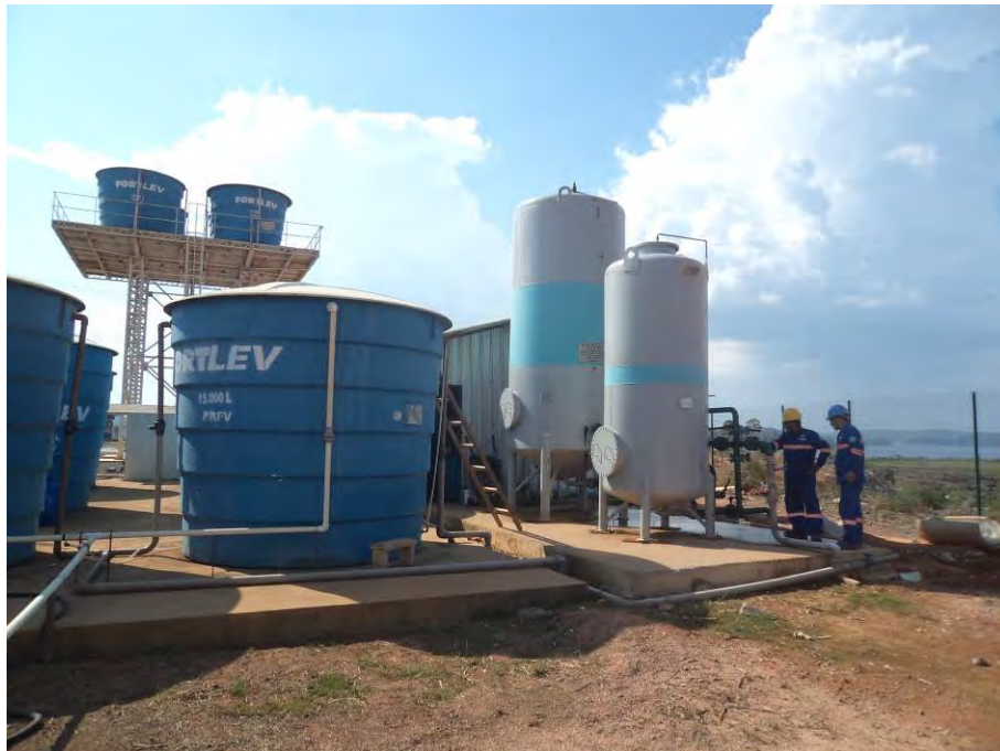
Figura 4.1.1 – Estação de Tratamento água do canteiro de obras.
