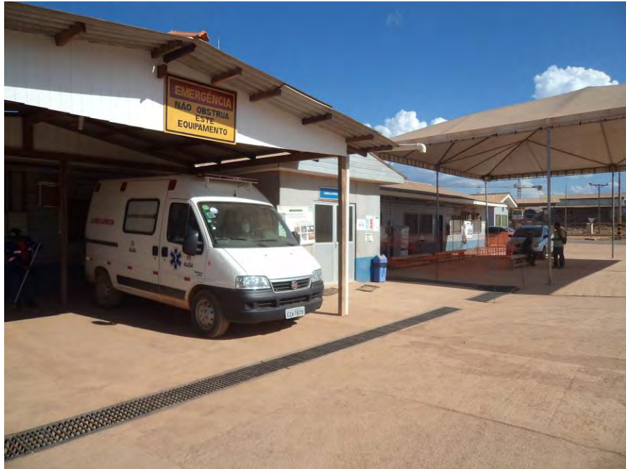
Figura 3.3.1 – Ambulatório do canteiro.
