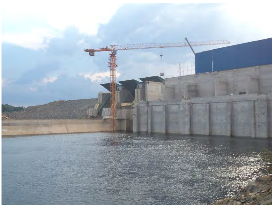
Figura 1.1.3 – Enchimento da Casa de Força a jusante (desvio do rio).
