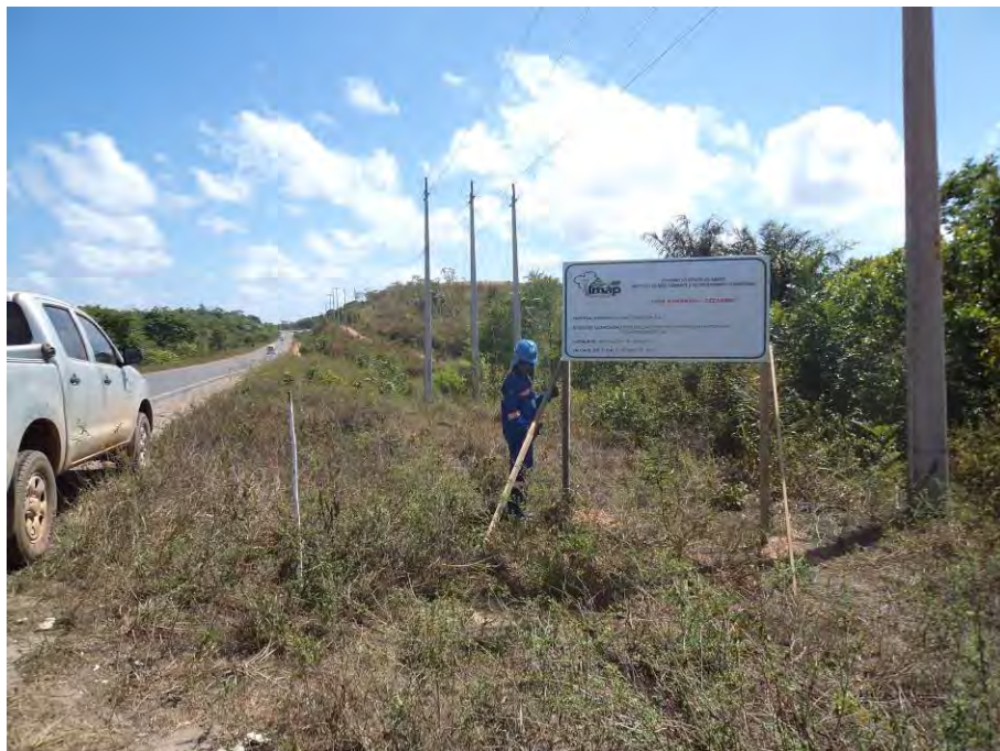
Figuras 5.2 – Instalação de placas de licenciamento ambiente nos trechos da BR-156.
