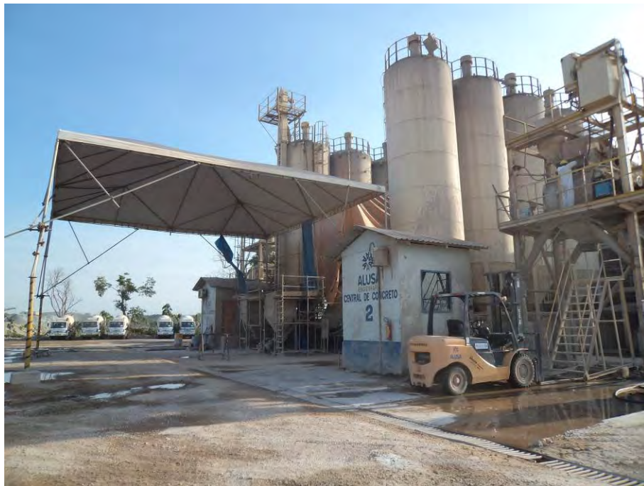
Figura 2.2.1 - Central de concreto.
