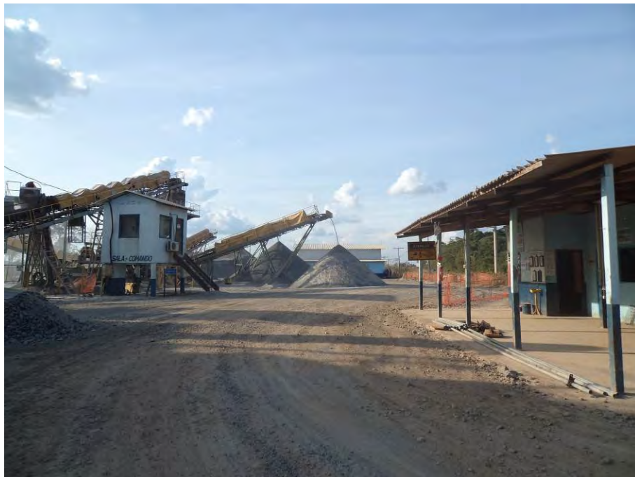
Figura 2.1.1 - Central de Britagem em operação.
