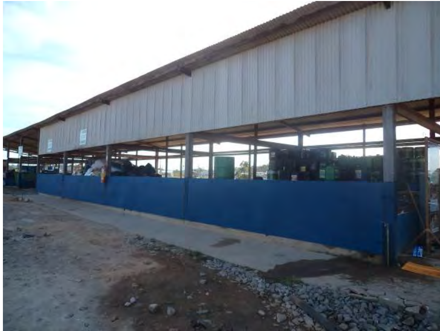
Figura 2.3.2 - Central de resíduos.
