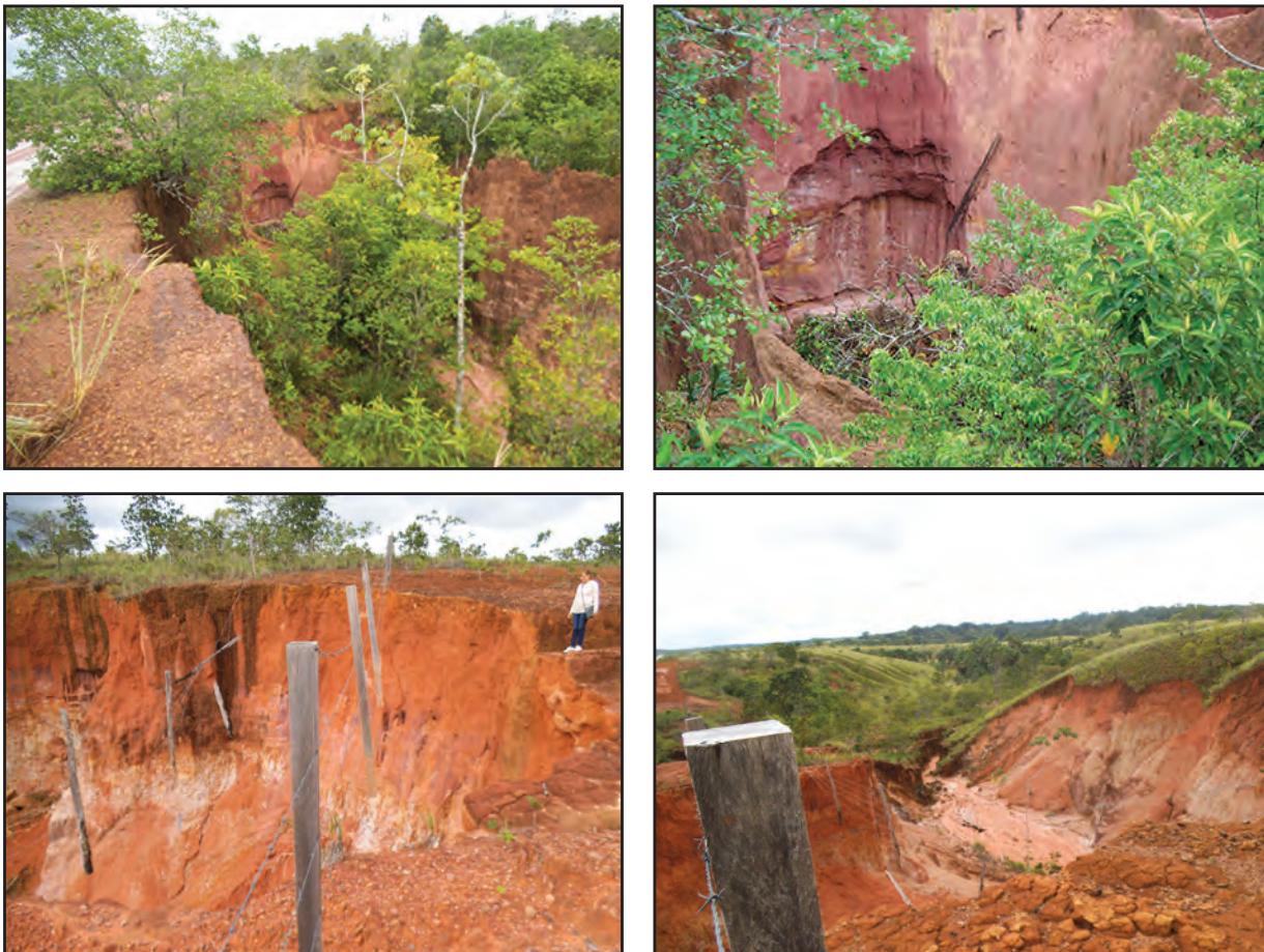
FIGURA 83. Processos erosivos próximos à BR 156.
