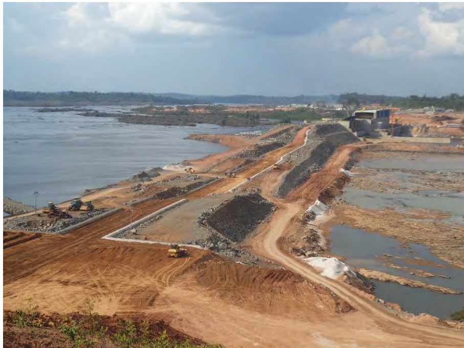
Figura 1.5.2 – Barragem Principal com 72% da estrutura concluída.
