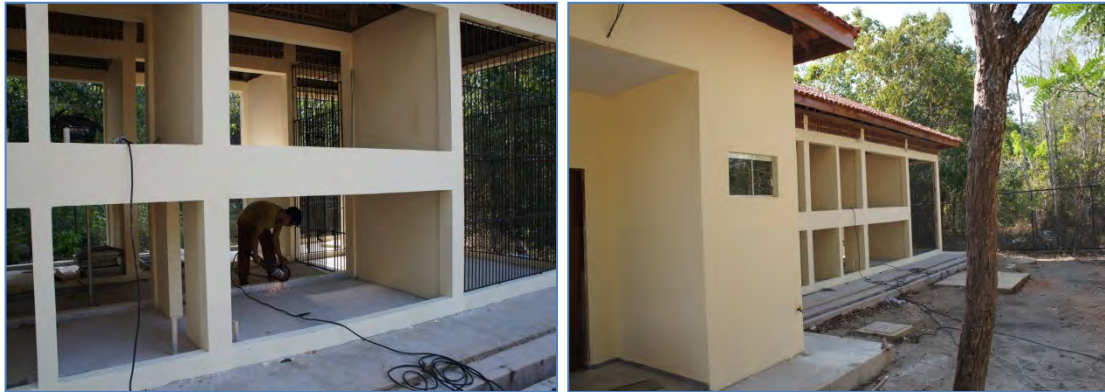
Figuras 1 e 2 - Obras de construção do quarentenário do CETAS IBAMA em Macapá
