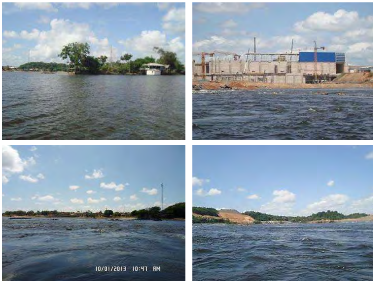
Figura 1. Fotos das vistas panorâmicas mostrando as condições no dia de monitoramento e da água nos arredores do local da construção da UHE Ferreira Gomes no Rio Araguari – Setembro/2013.
