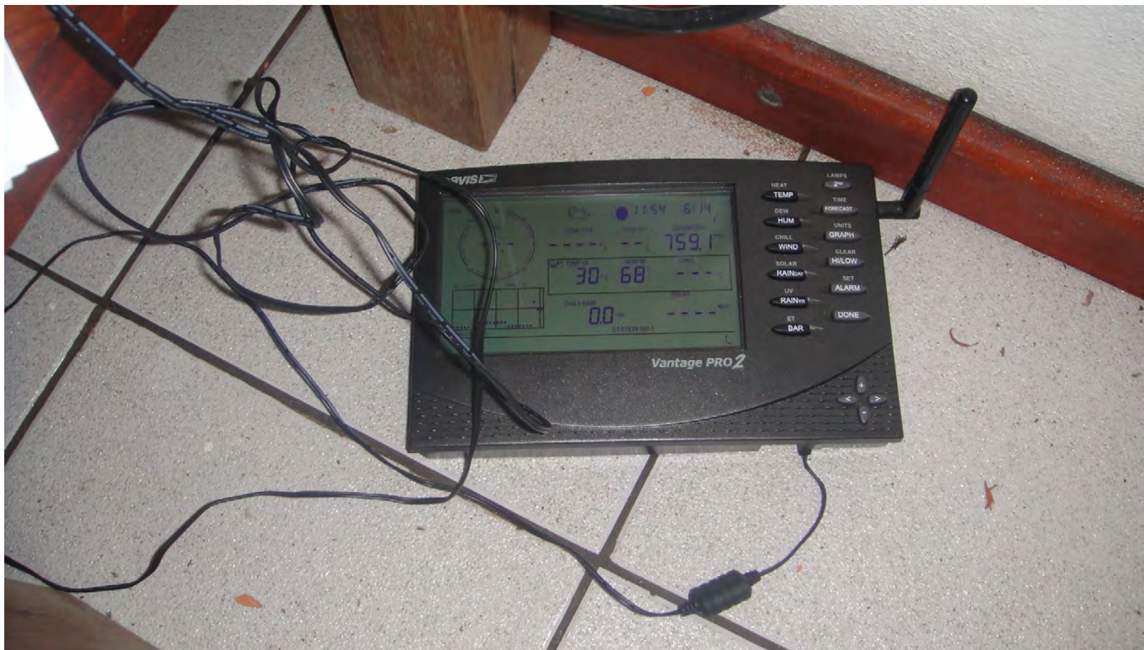
Foto 4 – Detalhe da estação meteorológica em funcionamento (unidade interna, instalada no AHE Ferreira Gomes).
