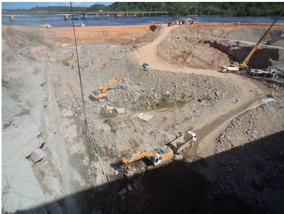
Figura 1.1.2 – Desmobilização da Casa de Força para realização do desvio do rio.
