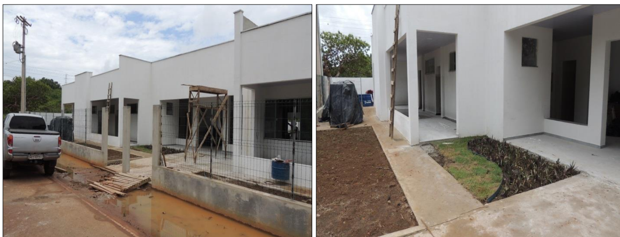
Foto 09 e 10 – Obras da Creche do Distrito do Paredão – Ferreira Gomes – AP
