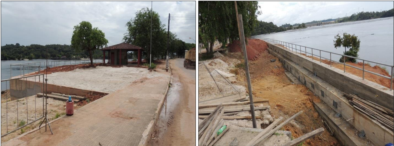
Foto 11 e 12 – Obra Muro de Arrimo – Ferreira Gomes – AP
