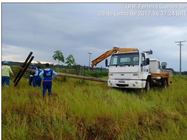
Fotos 06 e 07 – Trabalhos de retiradas de poste de concreto e limpeza geral da área
