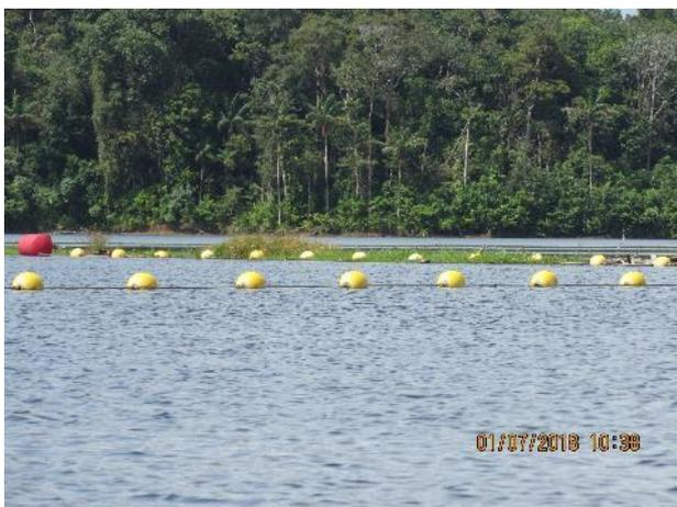
Identificação de banco de taboa à deriva, retido pelo *log boom* da UHE Ferreira Gomes.
