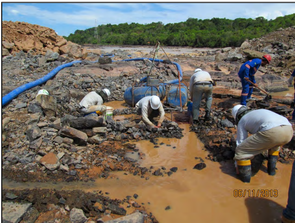
Figura 64: Bombas instaladas nas poças temporárias.
