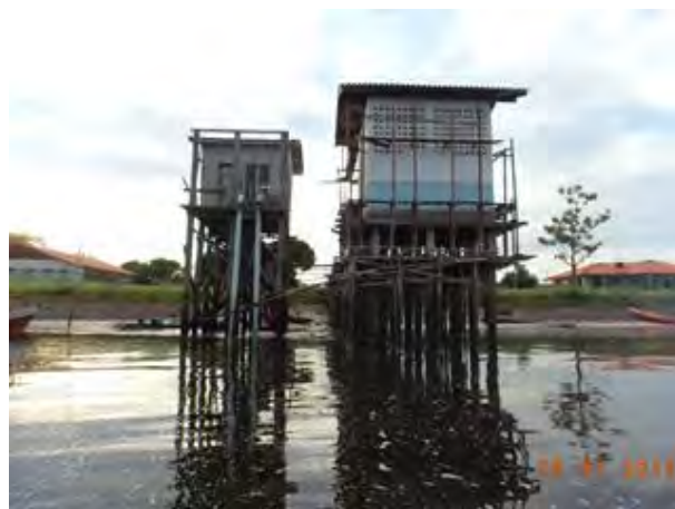
Figura 36. Foto da vista do Ponto Pt02FG, onde é feita a captação de água da CAESA para abastecimento da cidade de Ferreira Gomes.
