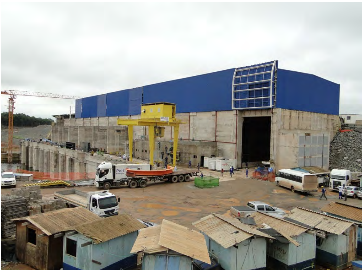
Figura 1.1 – Acompanhamento das edificações principais e áreas de apoio (vista a jusante).
