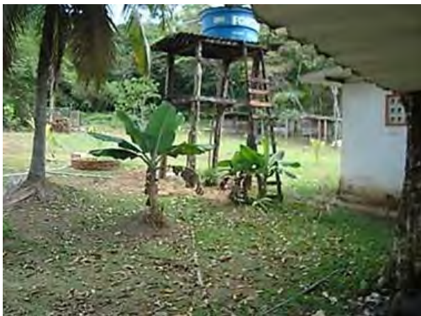
Figura 47. Foto mostrando o sistema de abastecimento por água de poço no Hotel Tassus (Pt13FG) a jusante das obras de construção da barragem. Foto obtida em 10. de outubro de 2013.
