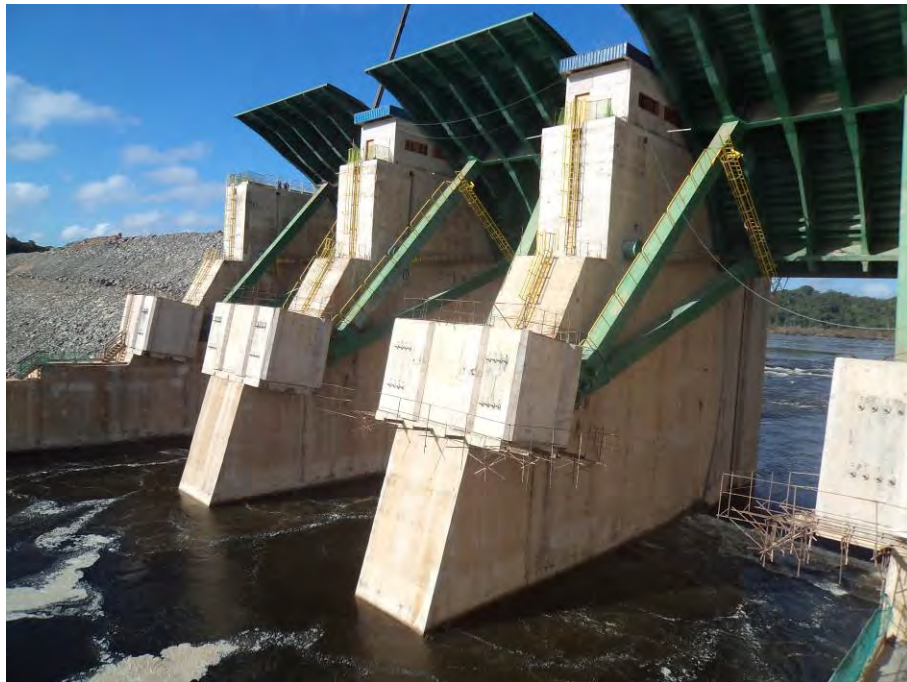
Figura 1.2.1 – Desvio do rio pelo Vertedouro.
