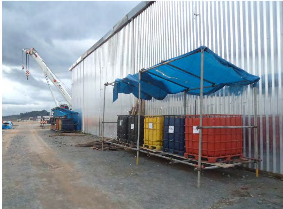
Figura 3.4.1.3 – Confeção de coletores com a reutilização de tanques de 1000L.
