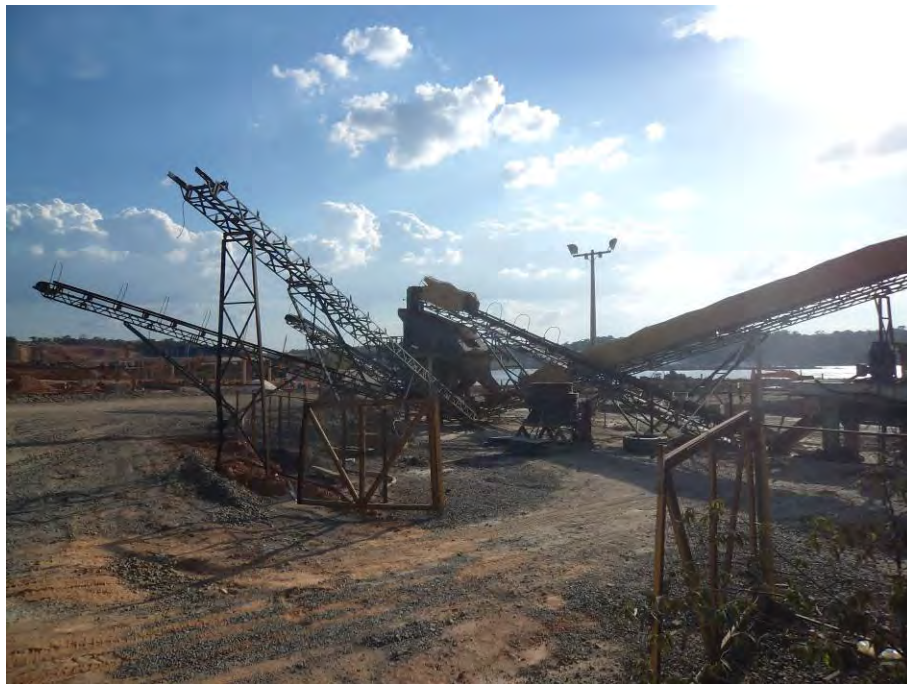
Figura 2.1.1 – Desmobilização da Central de Britagem 02.
