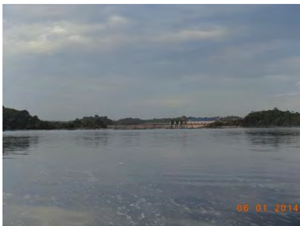
Figura 35. Foto da vista da ponte da BR-156 sobre o rio Araguari mostrando as condições climáticas no dia 06/01/2014.
