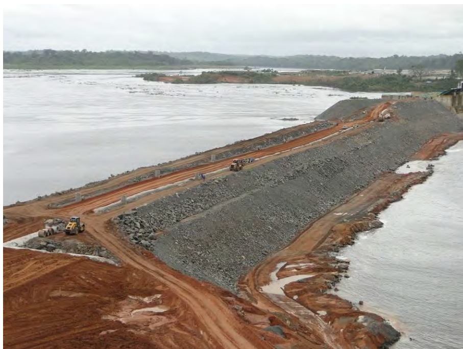
Figura 1.5.2 – Barragem Principal com 90,45% da estrutura concluída.
