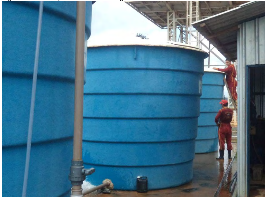
Figura 4.1.2 – Limpeza das caixas d'água pela contratada Extermínio.
