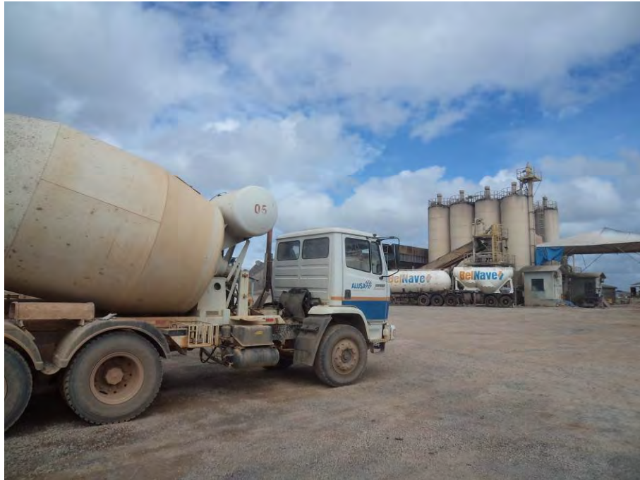
Figura 2.2.1 - Central de concreto.
