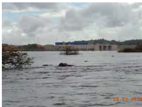
Figura 50. Foto da vista das obras do AHE Ferreira Gomes em 06/01/2014.
