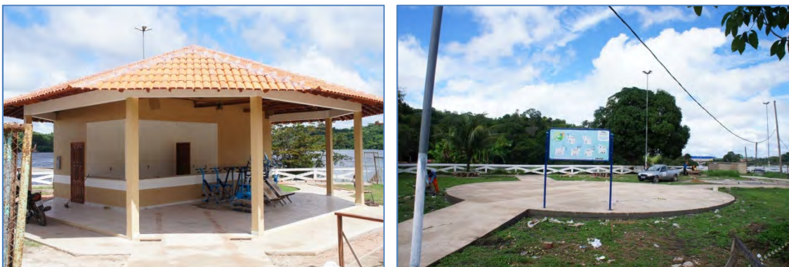
Figura 3 – Quiosque localizado na Praça Francisco Pinheiro Borges concluído / Figura 4 – Local onde serão instalados os equipamentos da academia ao ar livre.
