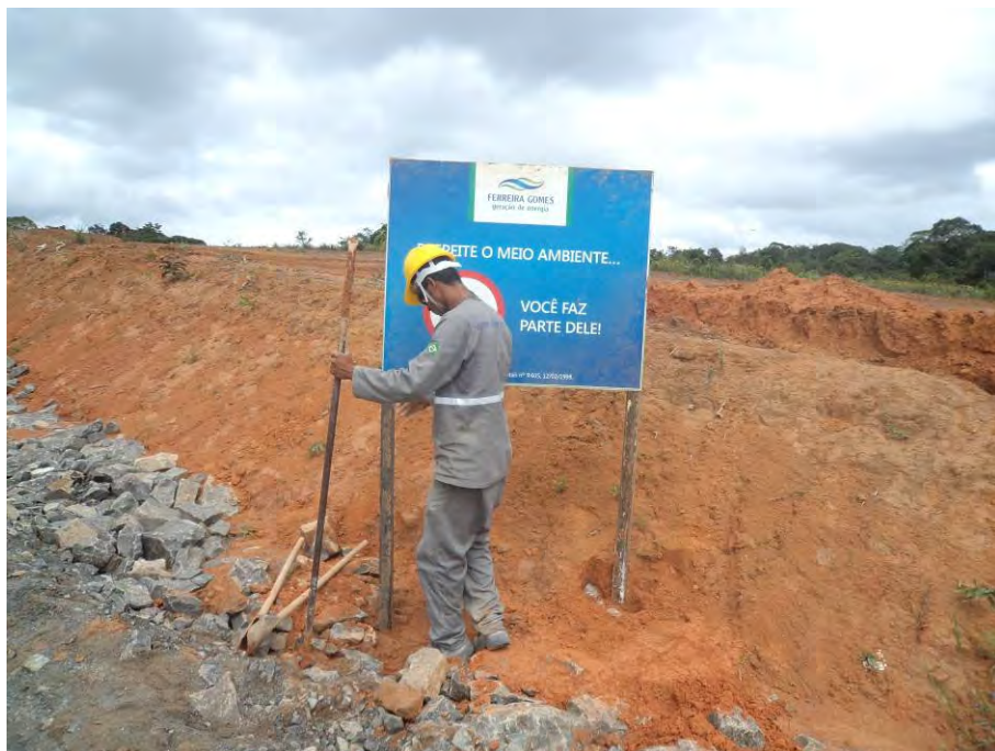
Figuras 5.1 – Instalação de placa de meio ambiente.
