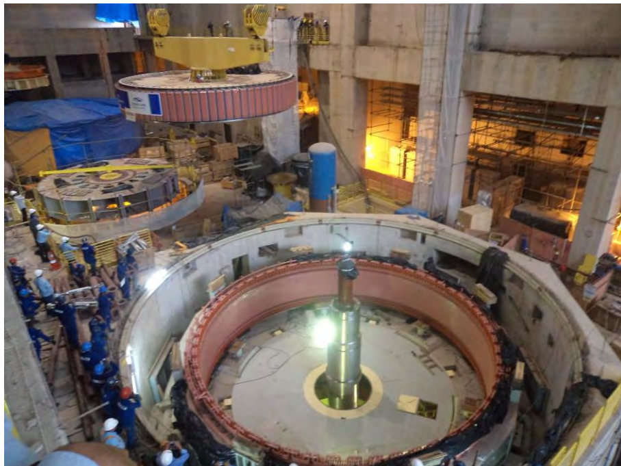
Figura 1.1.1 – Casa de Força 01
