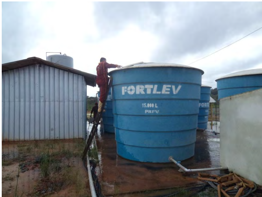
Figura 4.1.1 – Limpeza das caixas d'água do sistema de abastecimento do canteiro.
