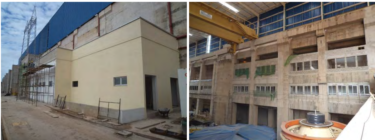
Figura 1.3.1 e 1.3.2 – Construção das alvenarias definitivas (salas de comando, escritórios, oficinas, entre outros).
