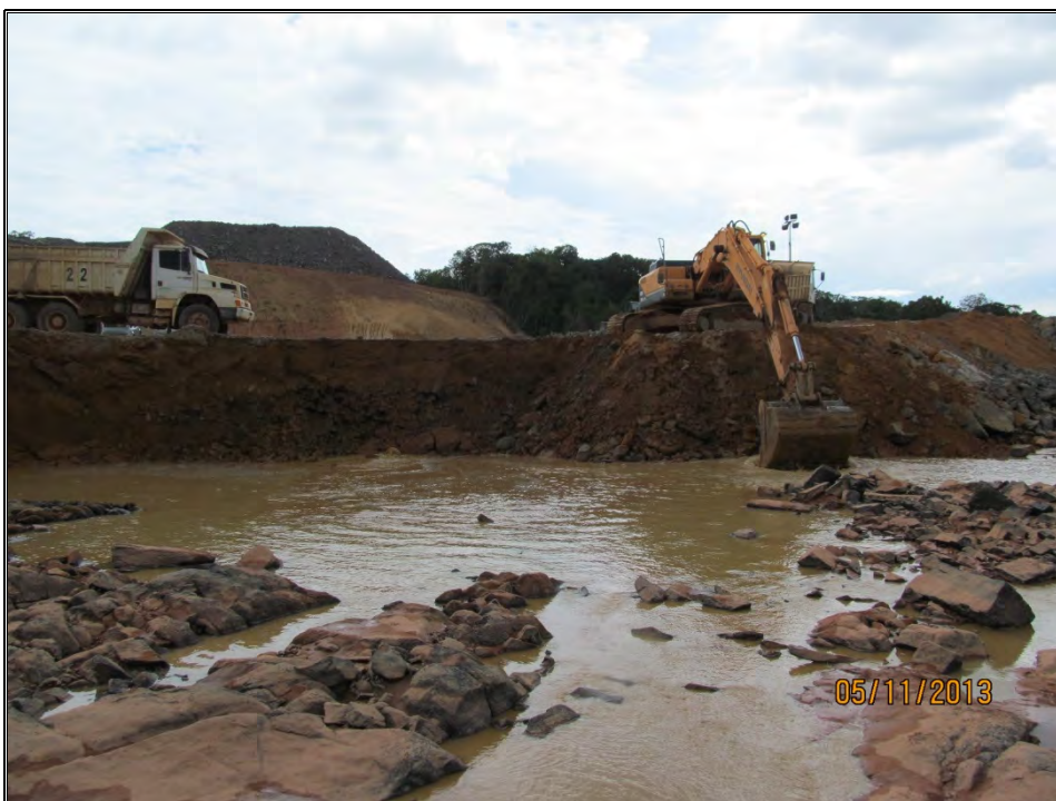
Figura 63: Maquinário pesado trabalhando nas áreas de formação da enseadeira.
