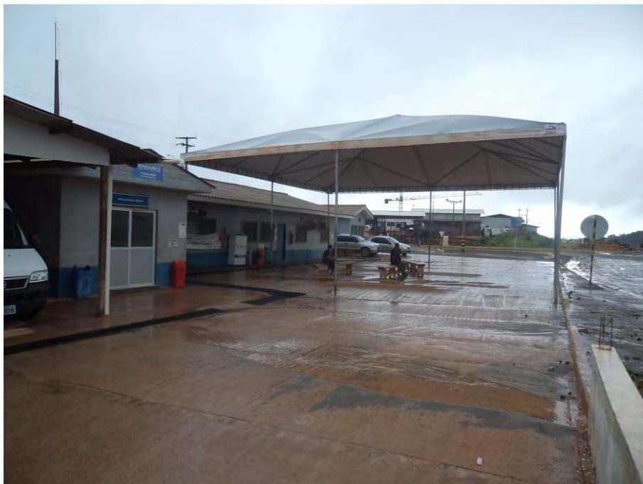
Figura 3.3.1 – Ambulatório do Canteiro.
