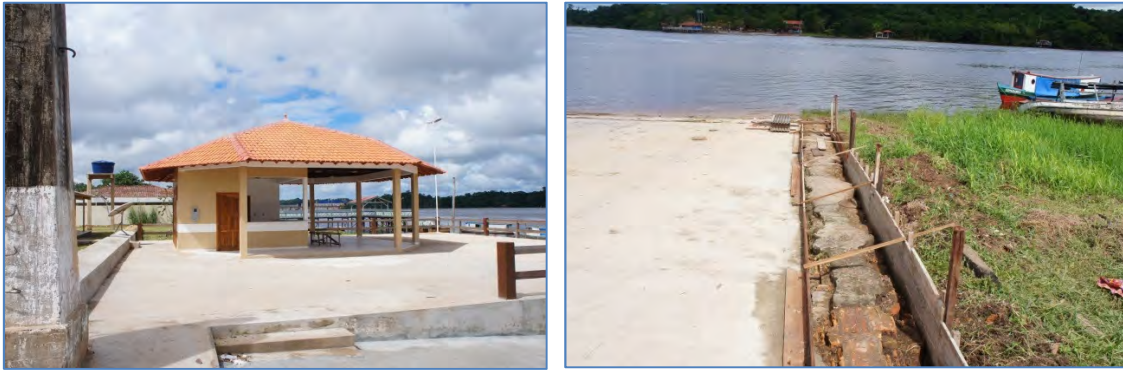
Figura 1 – Conclusão do primeiro Quiosque localizado próximo à rampa de embarque e desembarque / Figura 2 – Rampa de embarque e desembarque.
