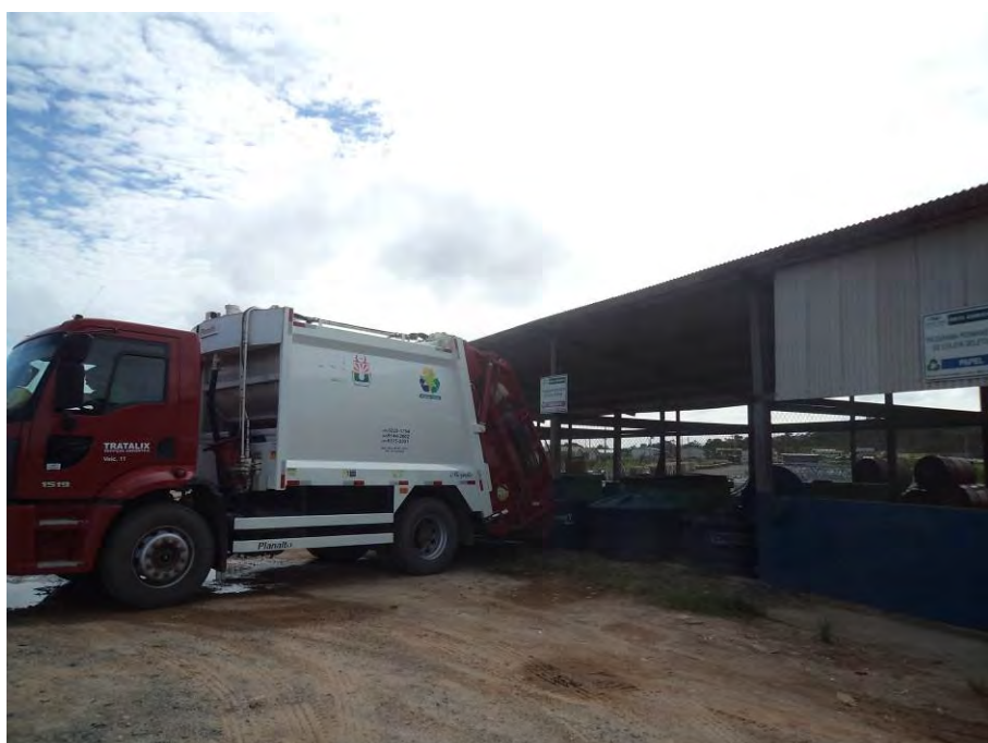
Figura 2.3.1 - Central de resíduos.
