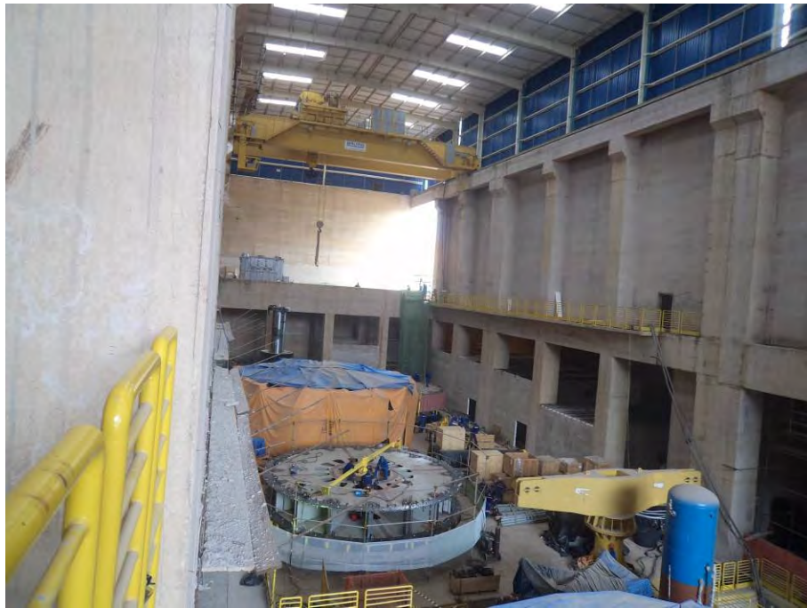
Figura 1.3.3- Área de montagem.
