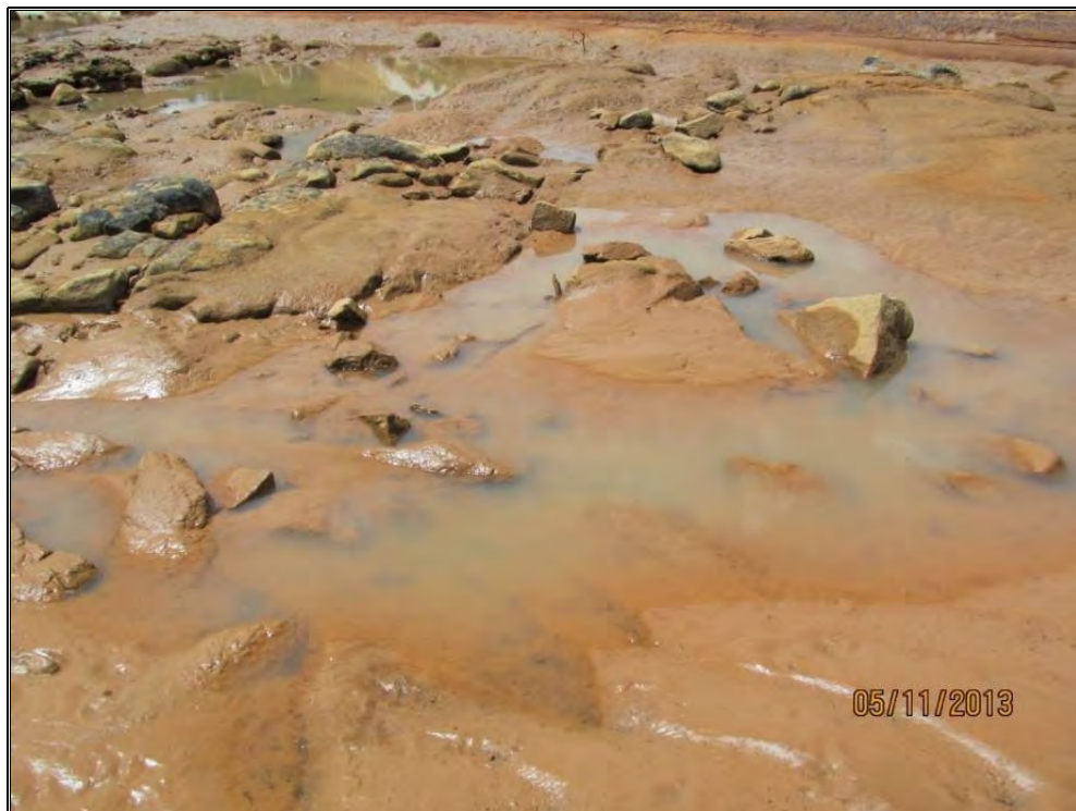
Figura 26: Depósito de sedimento oriundo do processo de formação da ensecadeira.
