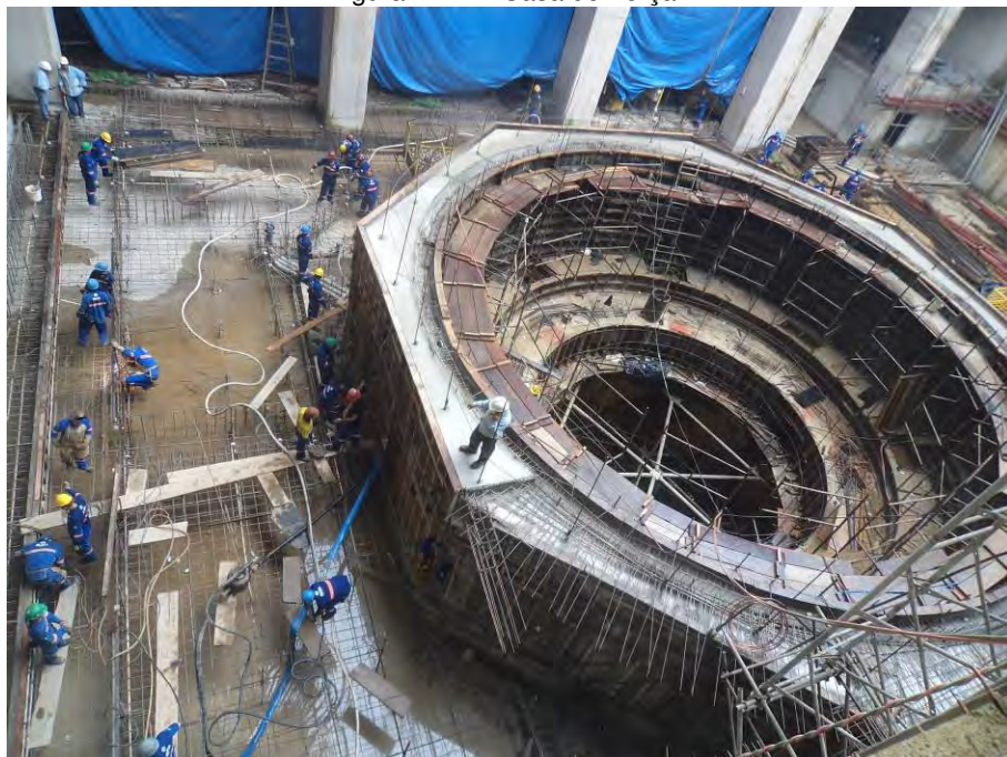
Figura 1.1.3 – Término da concretagem da Casa de Força 03.
