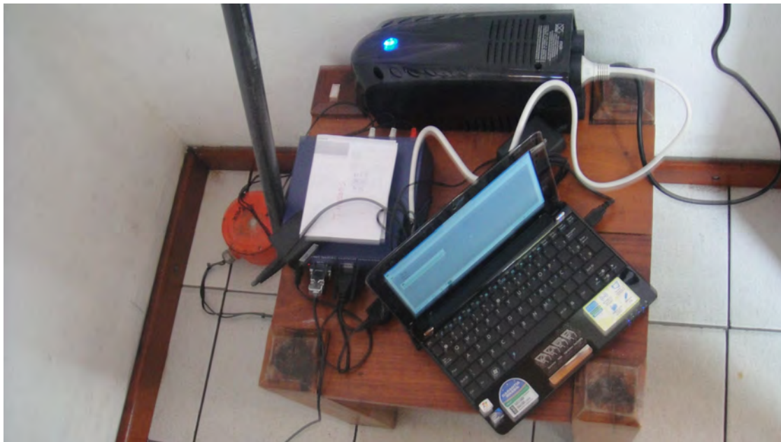
Foto 1 – Equipamentos instalados na localidade do AHE Ferreira Gomes.
