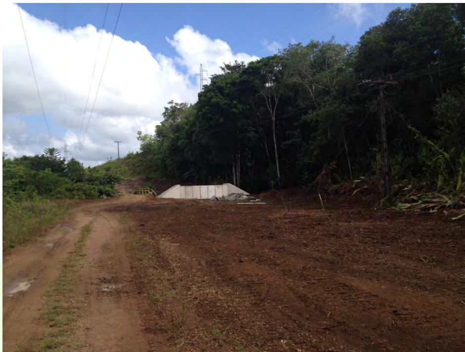
Figura 25– Trecho da trilha T1, com supressão da vegetação em borda de matas, durante a IX campanha de monitoramento do Aproveitamento Hidrelétrico Ferreira Gomes-AHE-FG.
