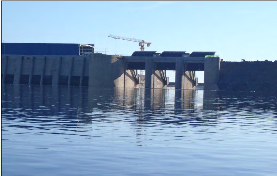
Figura 11- Canalização do rio Araguari pelo AHE Ferreira Gomes.
