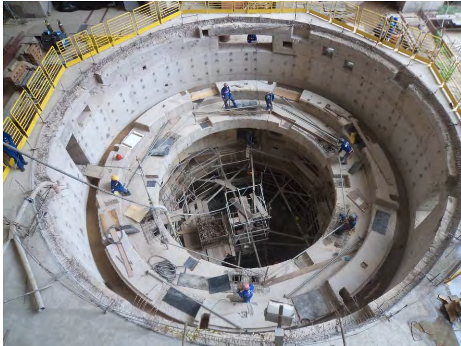
Figura 1.1.2 – Casa de Força .
