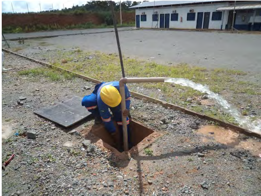
Figura 4.1.3 – Abertura dos hidrantes na limpeza das tubulações.
