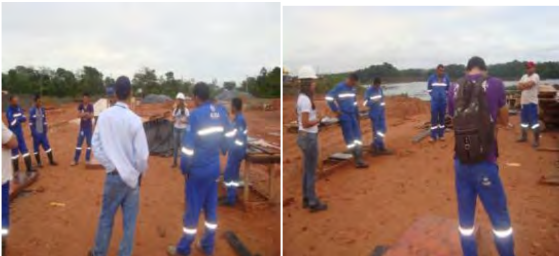
Figura 46- Dialogo de saúde com colaboradores da empresa ALUZA engenharia equipe de subestação dia 12 de dezembro.
