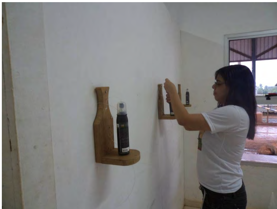
Figura 3.3.7 – Instalação dos repelentes coletivos.
