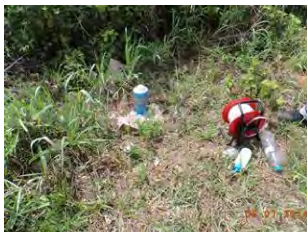
Figura 52. Poço de monitoramento localizado a montante das obras (Pt14FG). Nota-se que a grade de proteção da boca do poço foi retirada e há um canteiro de obras no local.
