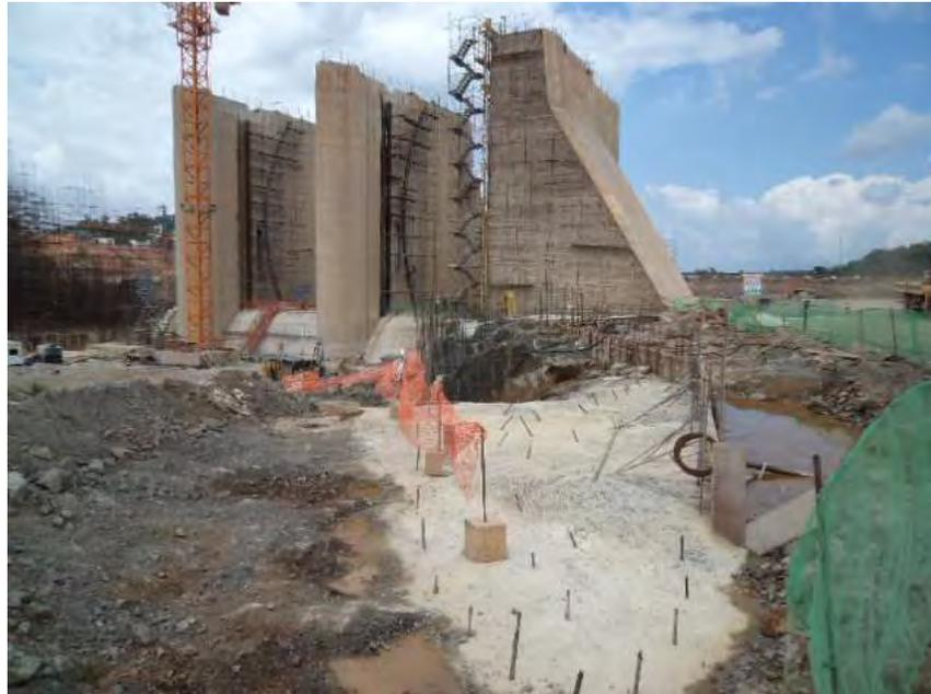
Figura 1.2.1 – Vertedouro montante, com fundação do muro de abraço.
