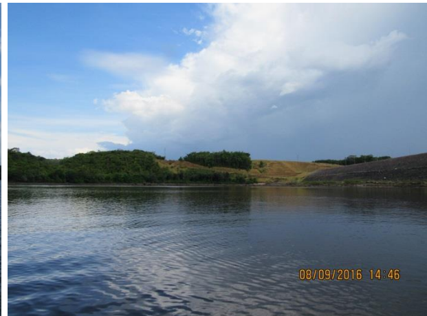
Figura 3.5 - Ponto de amostragem P04 (jusante da UHE Ferreira Gomes, no canal de fuga), setembro de 2016.
